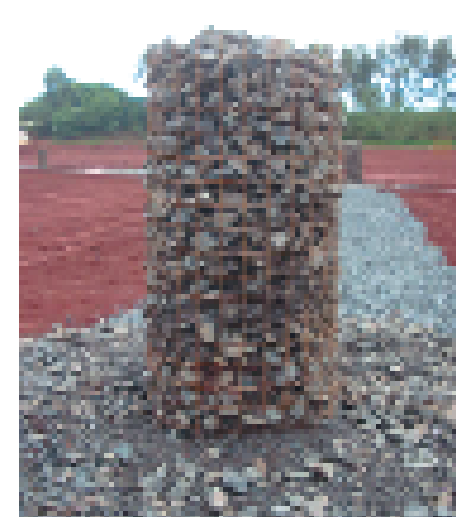
Sistema de drenagem de gases
