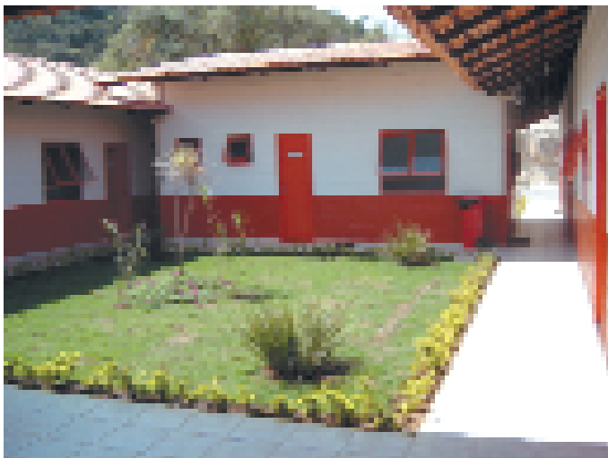
Instalações de apoio operacional
