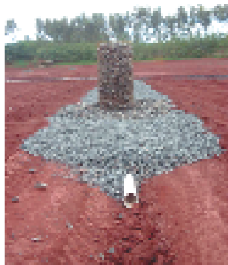
Sistema de drenagem de percolado
