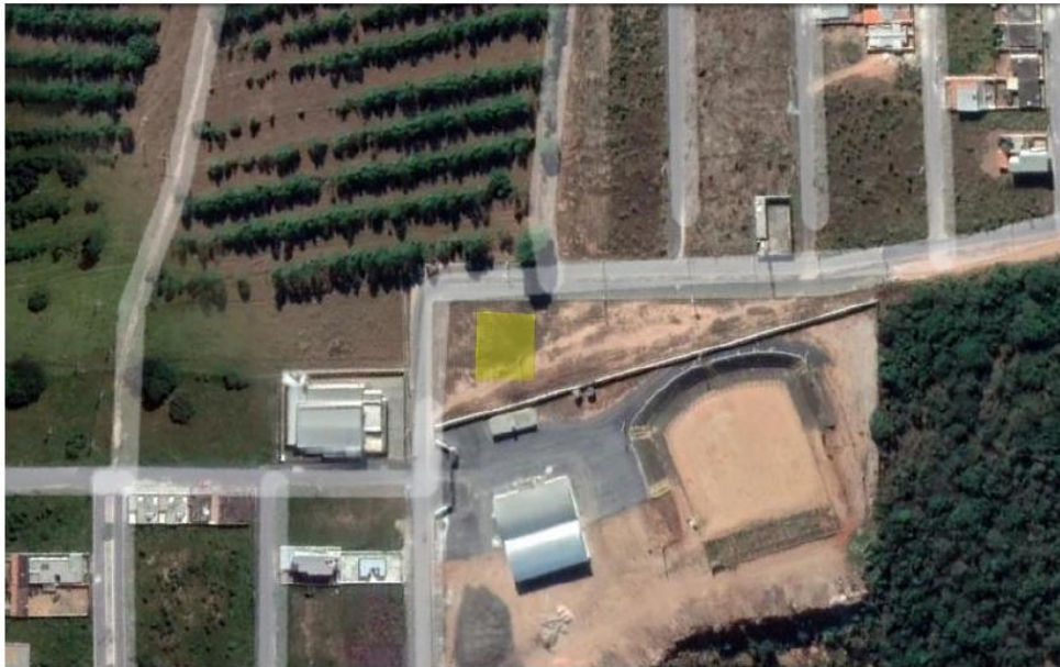
Imagem 01: Área de implantação da obra
