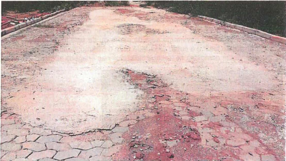
Figura 3 – Rua com muita deformação e remendor.
