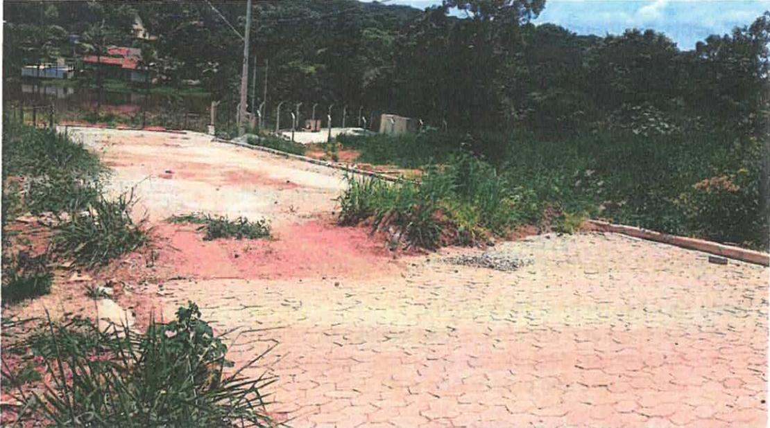
Figura 2 – Rua com muita deformação e remendor.
